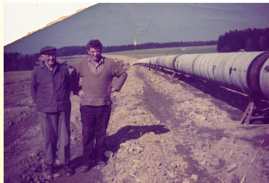
Stavba tranzitního plynovodu přes kyjovský katastr, Jan a Jiří Polreichovi z čp. 26, 1972 (JP).
