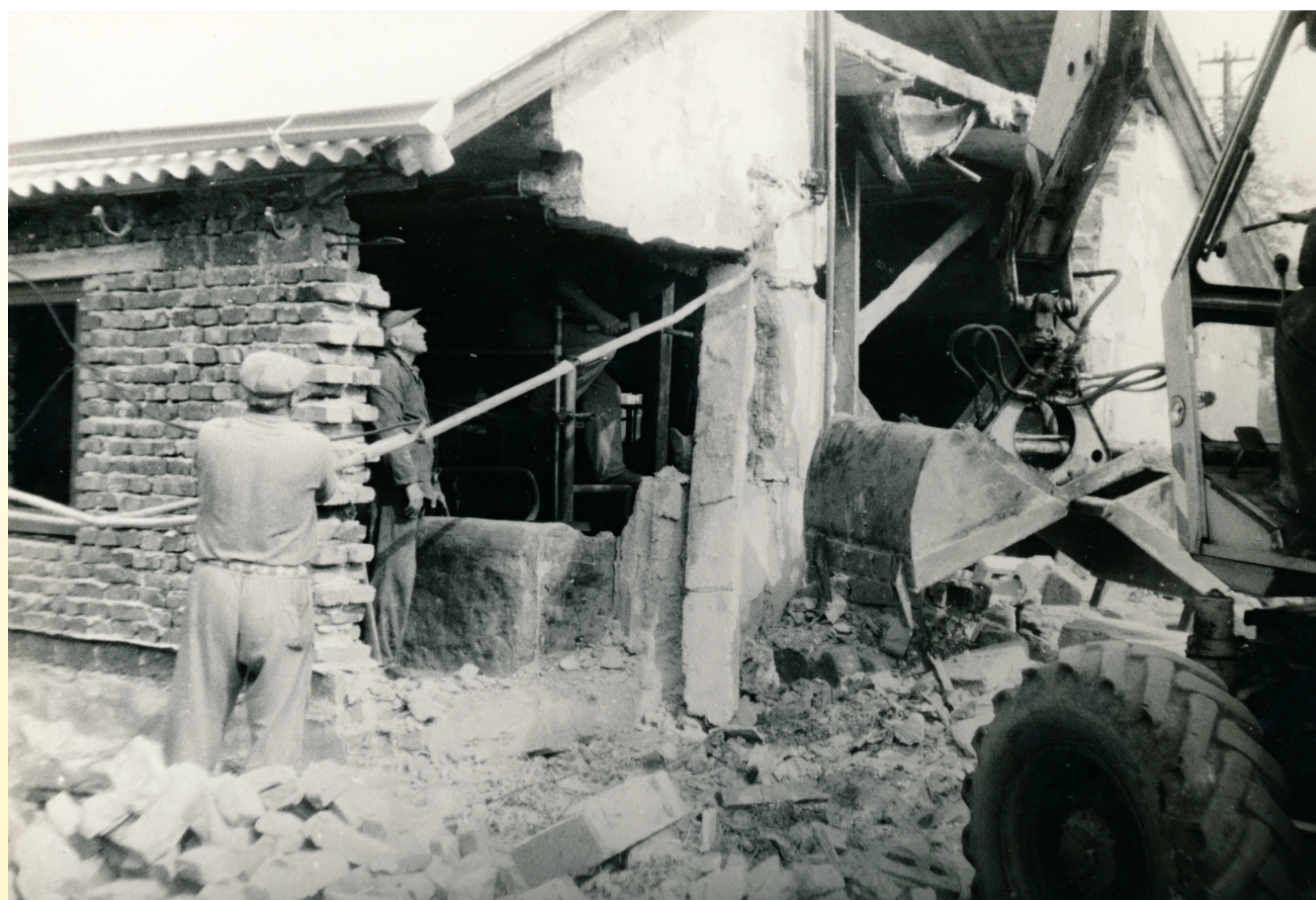
Přestavba kyjovského kravína, červenec 1982 (JH).
